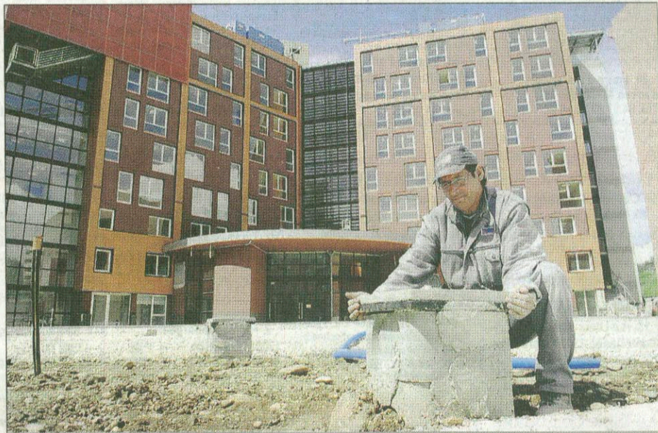
► Aux Flamants, le chantier bat son plein.
